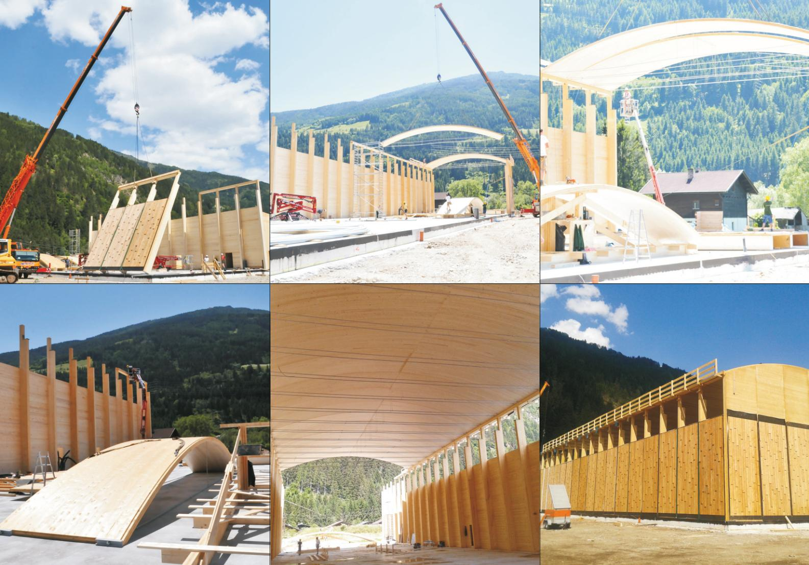
S sistemom rastrov in natačno določenega števila gradbenih delov je možno stroške in čas gradnje natančno določiti. Ukrivljena streha omogoča optimalno nosilnost, ki jo je možno doseči pri velikem razponu. Na podlagi visoke stopnje končanosti objekta je možno obdržati čas montaže na minimumu.
