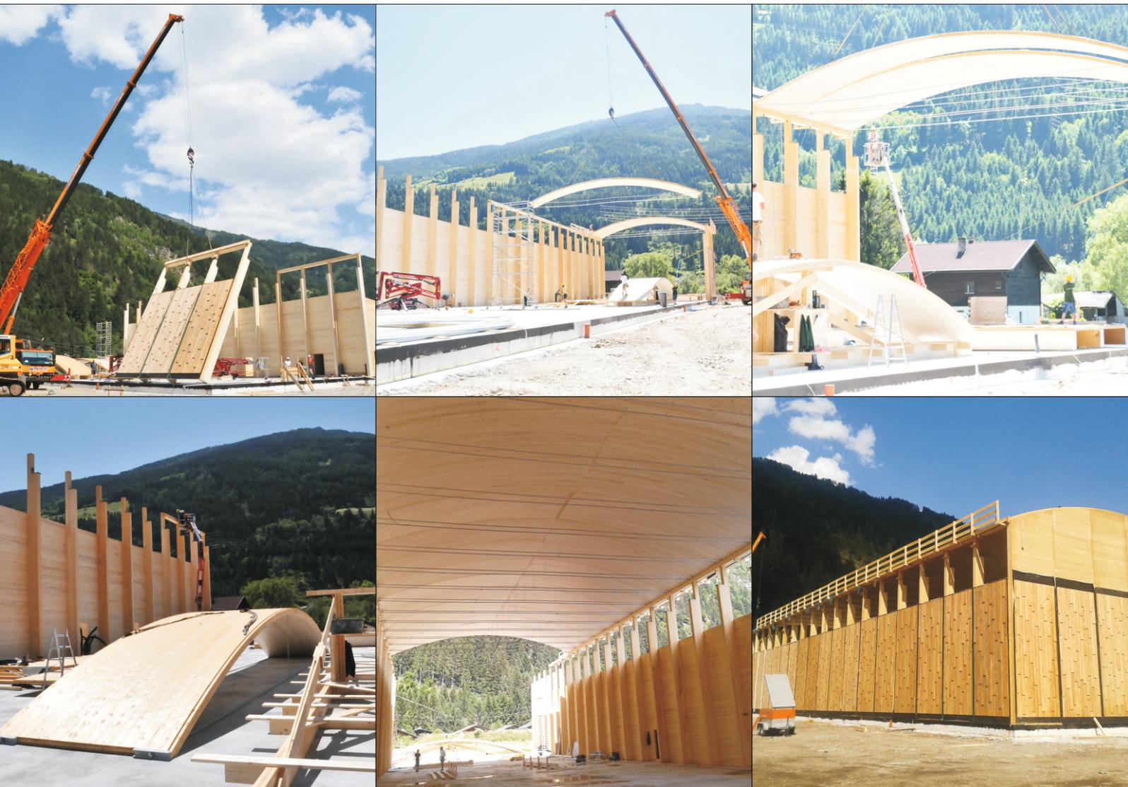
Con uno schema e un numero esatto di elementi di costruzione possono essere definiti precisamente i costi e tempi di costruzione. Il tetto a botte permette un ottimale scarico dei pesi, e possono essere raggiunti luci grandi. A causa del grado di prefabbricazione alta può essere ridotto il tempo di montaggio ad un minimo.
